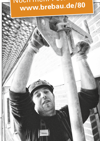
Harte Arbeit am Gerüst
