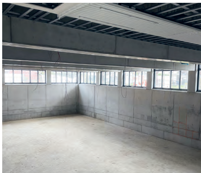
Die zukünftige Turnhalle
