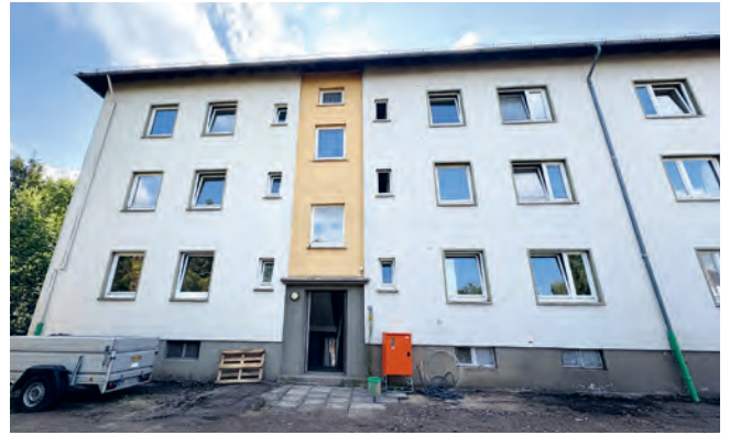
Hausfassade vor der Sanierung
