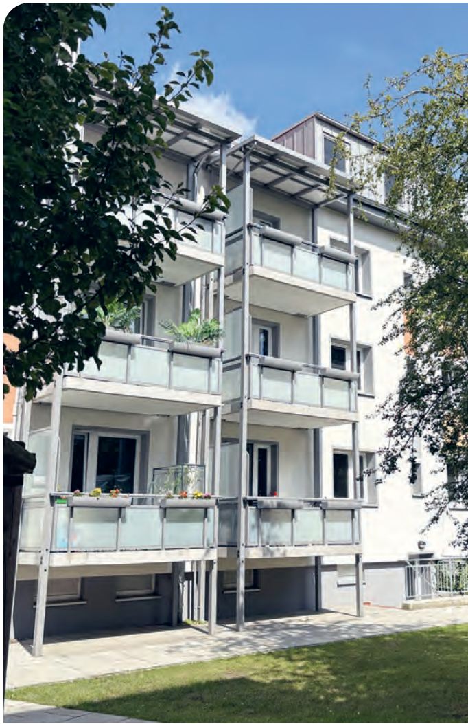
Die rückwärtige Hausfassade mit vorgestellten Balkonen nach Fertigstellung der Sanierung
