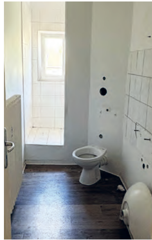
Bad vor und nach der Sanierung
