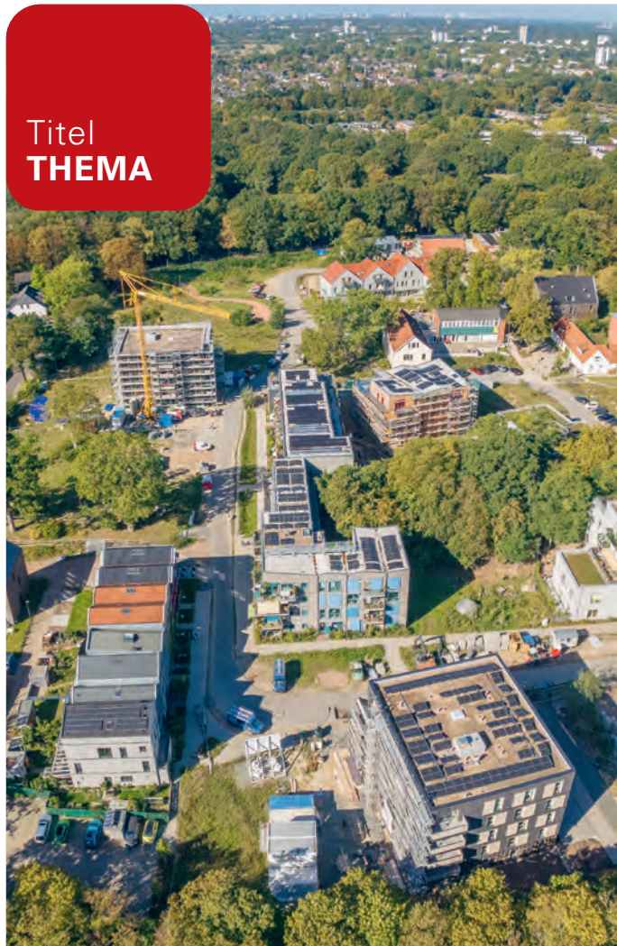
Blick von oben auf den Ellener Hof
