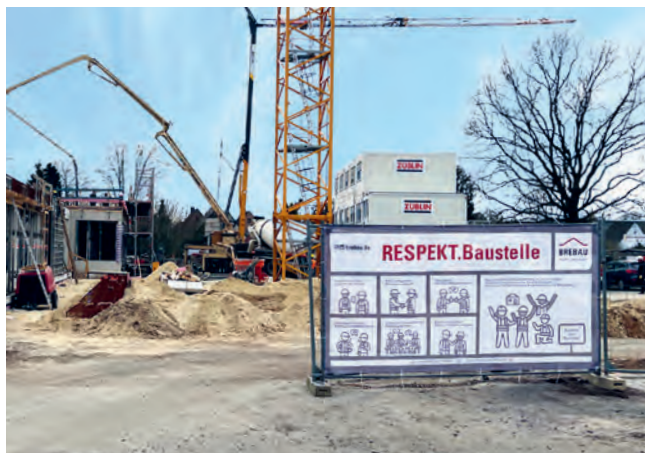
Das Banner RESPEKT.Baustelle auf einer Baustelle
