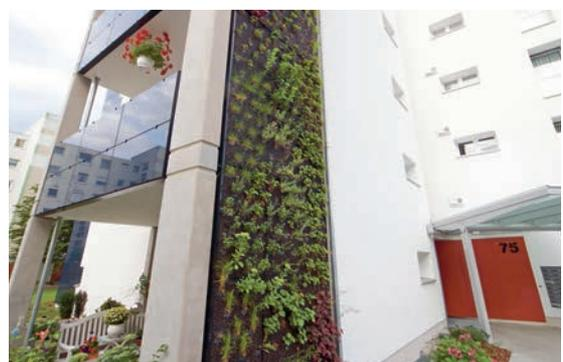
Abb. 5: Begrünung der Nordfassade, Photovoltaik an den Balkonbrüstungen
