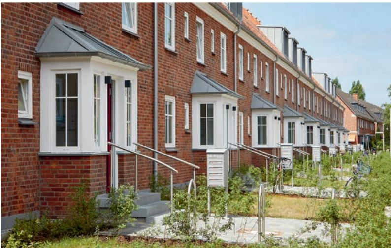
Im Zuge der Modernisierung wurde die Wohnfläche in den Dachgeschossen vergrößert. Das optische Erscheinungsbild wurde erhalten, wobei die Außenwände nicht von außen, sondern von innen gedämmt wurden. Zur Verbesserung des Feuchte- und damit auch des Wärmeschutzes erhielten sie eine neue Verblendverfugung und eine Hydrophobierung. Die Fenster wurden gegen solche mit Wärmeschutzverglasung ausgetauscht.
