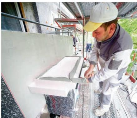
Abb. 4: Neue Dämmung der Fassade
