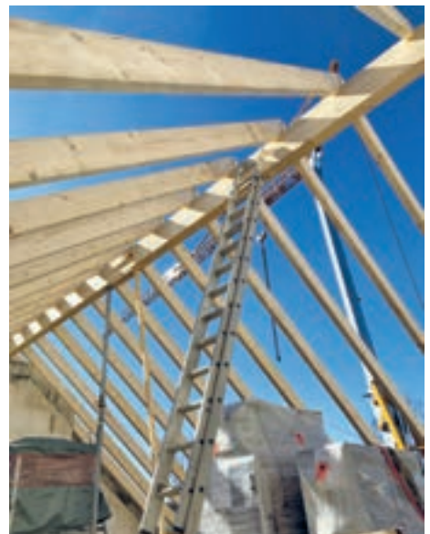
Der Bau der KiTa nimmt Formen an
